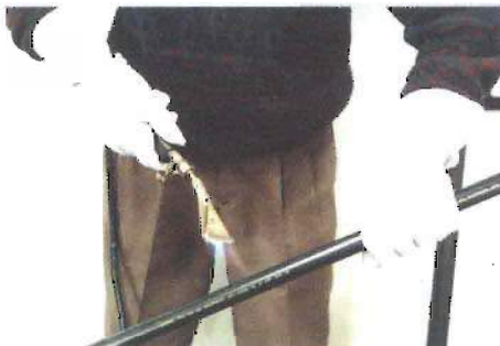
Curva em eletroduto com maçarico.
