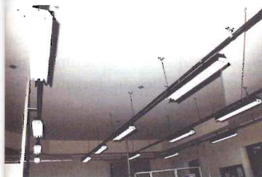
Instalação com perfilado.
