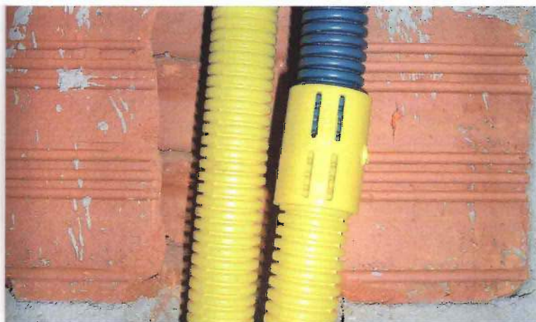
Emenda de eletroduto flexível e rígido.
