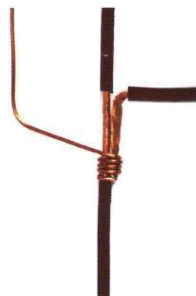
c) Derivação com condutores rígido e flexível.
