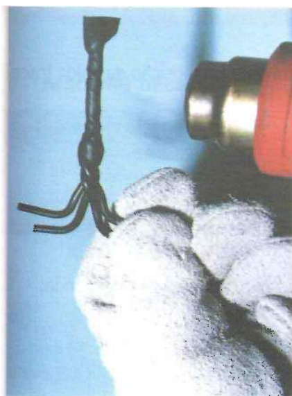
Aplicação de isolante termocontrátil.
