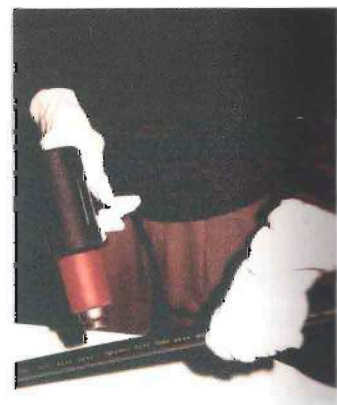
Curva em eletroduto com soprador térmico.
