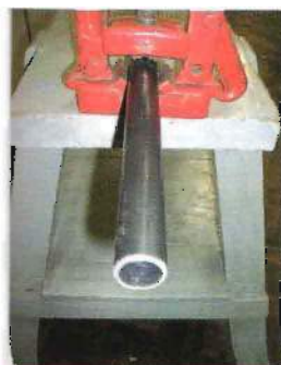
Cortar perpendicularmente, escarear e remover rebarbas do eletroduto.
