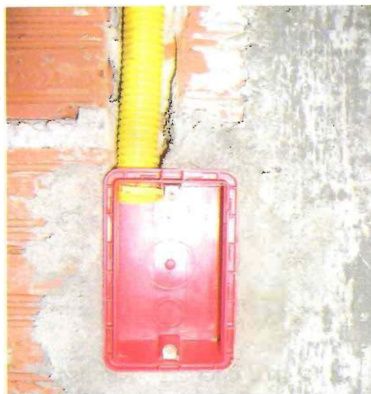
Fixação de eletroduto para reboco.
