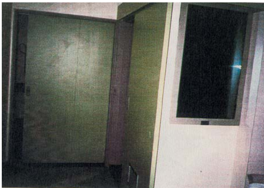
Foto 20 – Visualização da porta de entrada da sala de Tomografia e Sala de Comando
