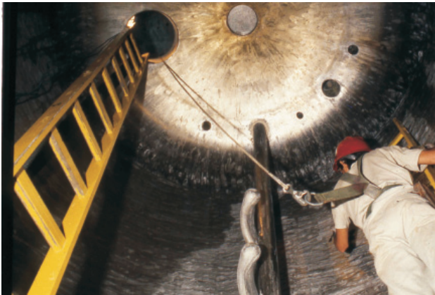
Figura 12.3 Trabalhador procedendo a limpeza interna do reator. Cuidados de prevenção adequados devem ser utilizados sempre nesse processo.
