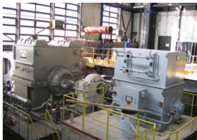
Fornecimento: 12.000 kW, 6.000 V, 4 polos, IC81W Aplicação: Compressor centrífugo
