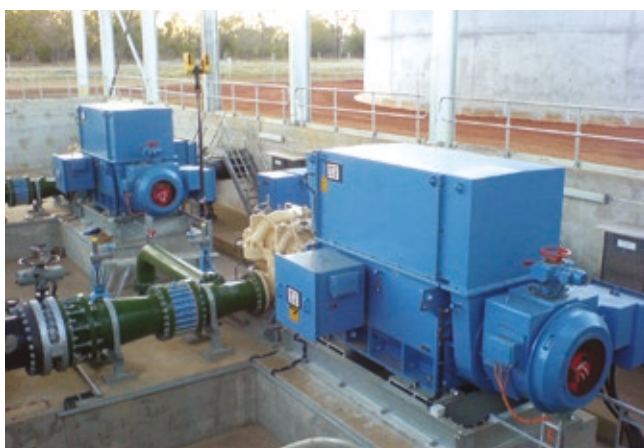
Fornecimento: 2.000 kW, 11.000 V, 4 polos, IC611 Aplicação: Bomba de água
