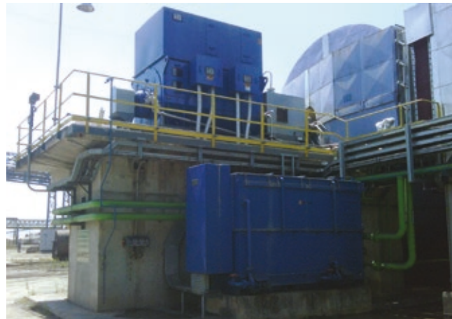
Fornecimento: 9.000 kW, 6.600 V, 8 polos, IC81W Aplicação: Exaustor
