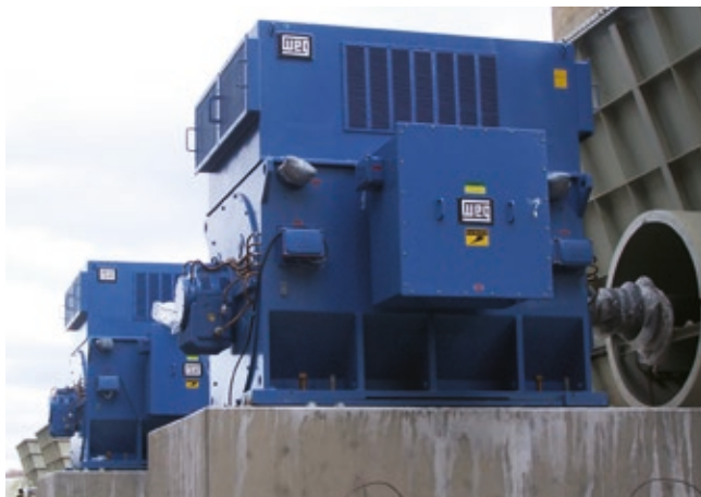
Fornecimento: 9.900 HP, 13.200 V, 8 polos, IC01 Aplicação: Ventilador
