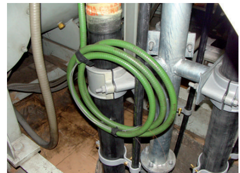
Fig. 5. Fase central da nova LD BH Adelaide - BH Carlos Prates, 138 kV com as fibras ópticas lançadas.
