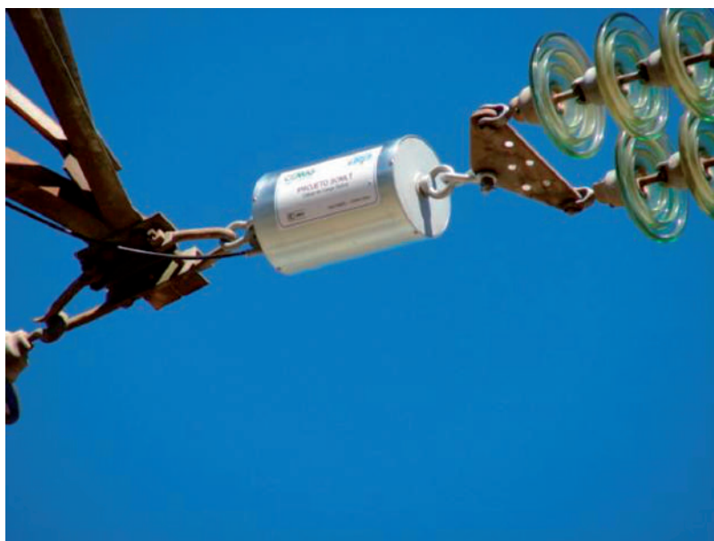
Figura 4 - Detalhe da instalação da célula óptica em estrutura de ancoragem de linha aérea tipo 138 kV da Cemig D
