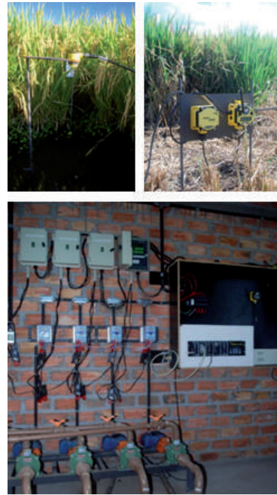
Figura 4. Detalhes da instalação do projeto: sensor ultrassônico; transmissor sem fio e sala de controle local.
