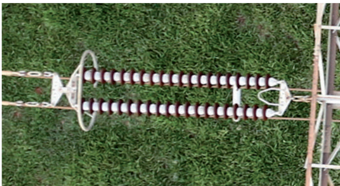
Figura 3 – Detalhe dos isoladores
