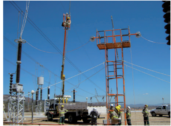
Figura 2 - Chave em uso para retirada de TPC de 345 kV.
