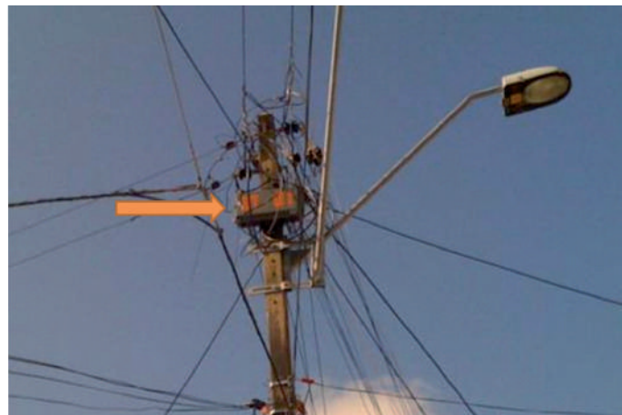
Figura 5. Protótipo instalado no poste da rede de distribuição para atendimento de cinco UC monofásicas
