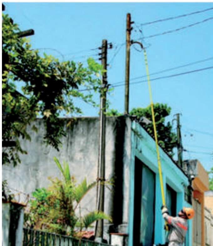
Figura 1: Um técnico instalando o dispositivo eletrônico em uma conexão de entrada de um cliente da AES Eletropaulo.
