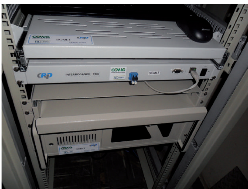
Figura 3 - Sistema de interrogação óptica das informações em tempo real
