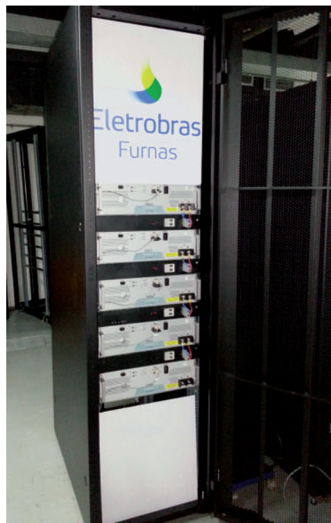
Figura 1: Sistema lítio-íon montado pela Eletrobras Furnas e instalado no Centro de Operações
