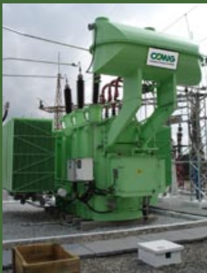
Transformador revitalizado
