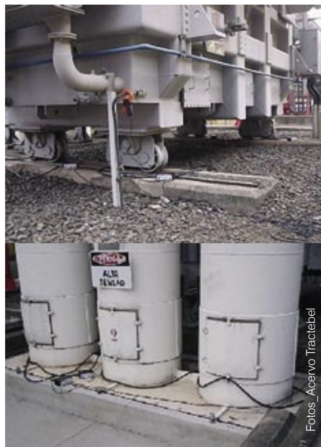
Medição de correntes nas quatro rodas de apoio do transformador (acima) e das correntes “líquidas” na blindagem dos dutos de baixa tensão com as bobinas de Rogowski posicionadas na base das blindagens (abaixo)
