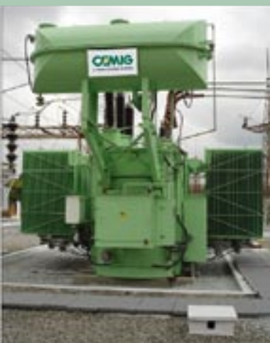
Transformador revitalizado
